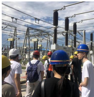
电力学院本科生变电站现场实习
